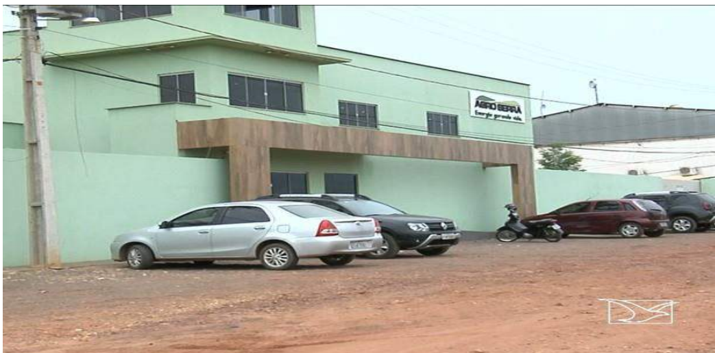
Figura 06: Fachada Agro Serra.
